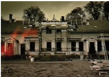
Foto viser hovedbygningen under ombyggingen som NSB foretok i 1921.
