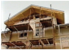
I perioden 1992-1996 total rehabiliteres eiendommen, her lettes fasadearken opp til originalt nivå.
