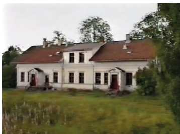
Forfallet var i 1991 meget omfattende og den tidligere stasbygningen var et bedrøvelig syn.
